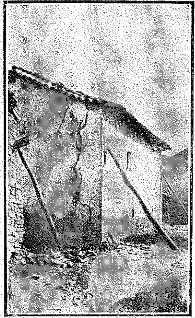
Fig. 16 Casa agrietada en Martes
